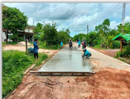
6. โครงการก่อสร้างถนน คสล.สายทางรอบหมู่บ้าน หมู่ที่ 6
