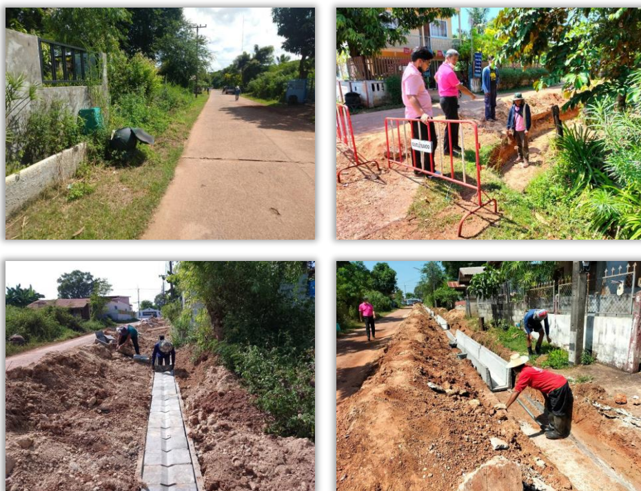
10. โครงการก่อสร้างรางระบายน้ำคอนกรีตอัดแรงข้างถนนสายวัฒนธรรม-บ้านนางอบสินทร หมู่ที่ 8
