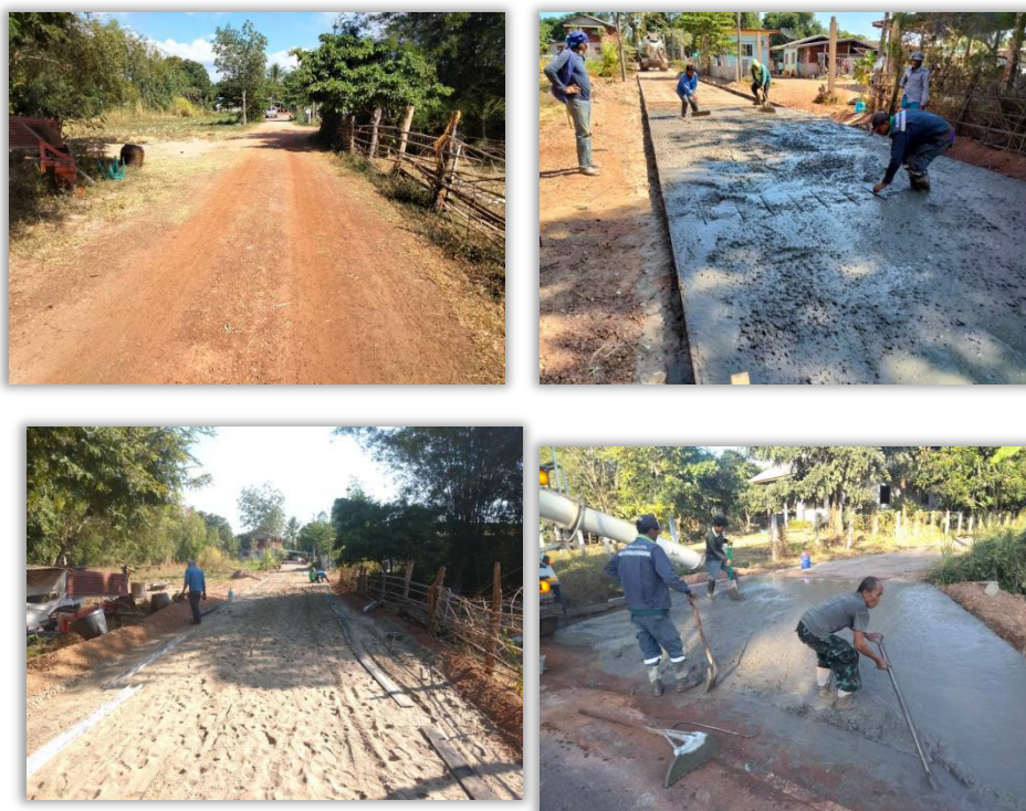
17. โครงการปรับปรุงถนนสายสี่แยกร้านสินทรรุ่งเจริญ-โรงเรียนอนุบาลพิบูลย์รักษ์ หมู่ที่ 1
