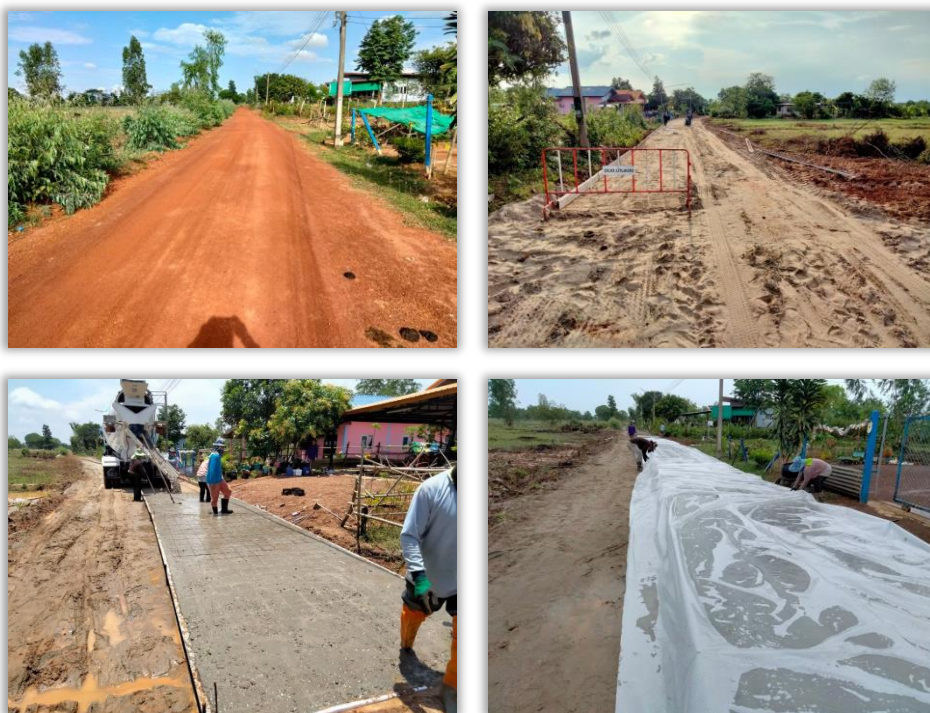
9. โครงการก่อสร้างรางระบายน้ำคอนกรีตเสริมเหล็กจากนายนายพัฒพงษ์ สีจันทร์ - โรงขนมจีน หมู่ที่ 15
